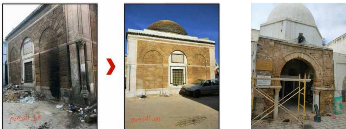
Figure 5 : à droite : Masjid Ibn Khaldoun en cours de restauration, à gauche : Torbet Al Fallari avant et après la restauration, Source : INP
