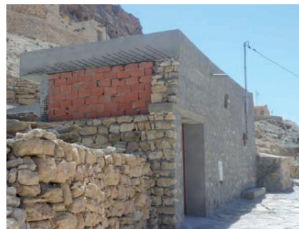
Figure 9. Introduction du béton et de la brique rouge creuse (Khatalli et al., 2015)
