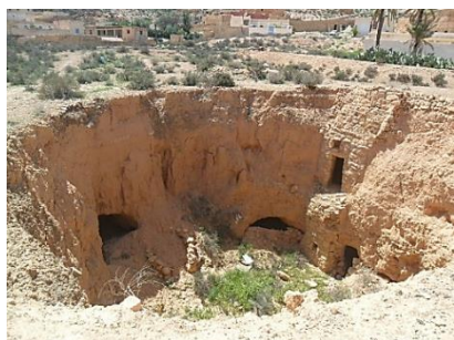
Figure 5. Effondrement des murs du patio (Auteure)
