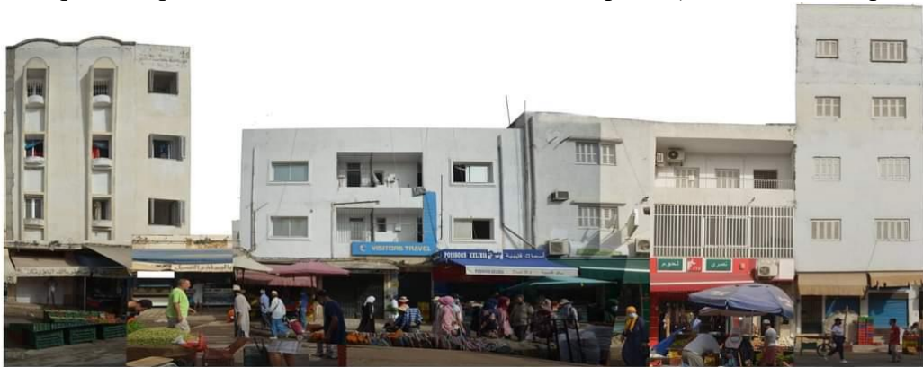
Figure 12: Une partie de la façade de rue Sidi Ammar, un témoignage des étages au sein de l'ancienne ville, Source : Projet Ariana cœur battant, septembre 2021
